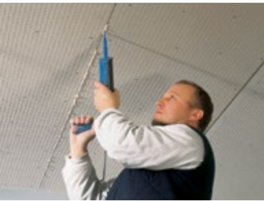
Derzler el tabancası ile doldurulur...
